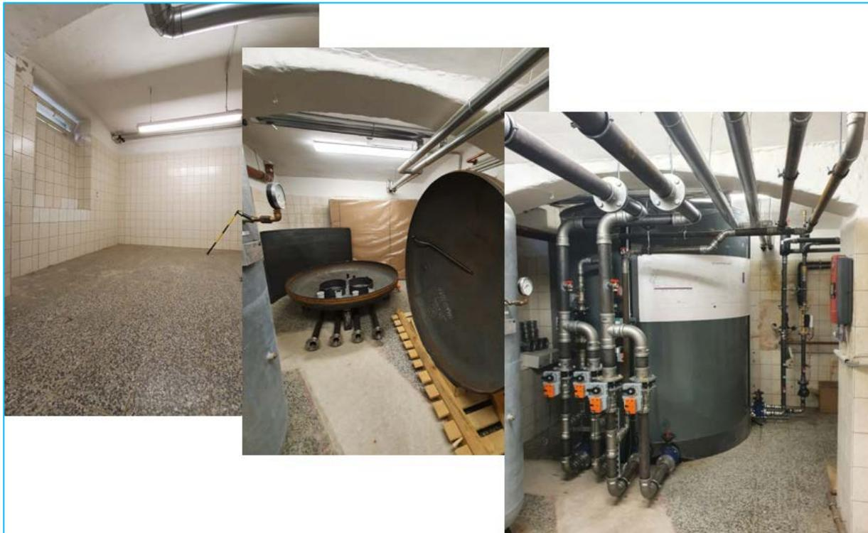
**Abbildung 44: Platz für Pufferspeicher leer (links), mit Bauteilen des Pufferspeichers (Mitte) und fertig montierter Pufferspeicher (rechts)**
