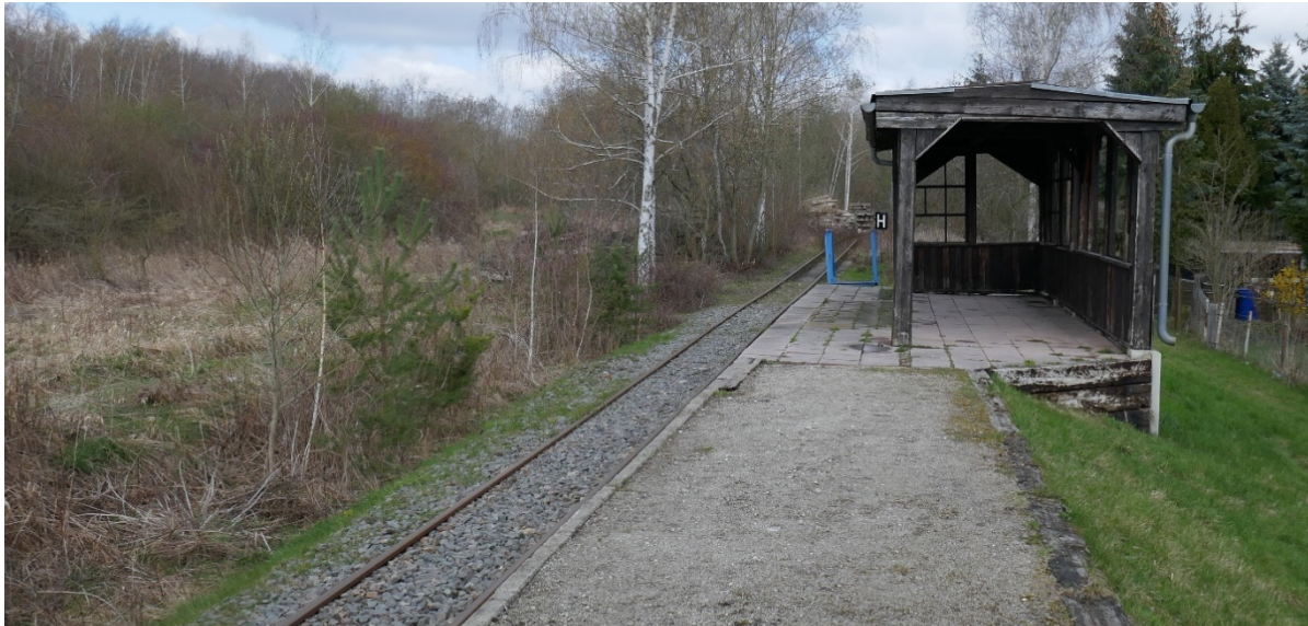
Endhaltepunkt in Regis-Breitingen, beispielhaft für den Zustand der Kohlebahn
